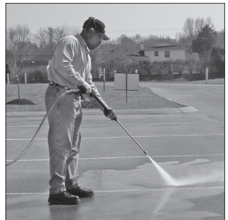
Figura 21 - Angle optimum par rapport à la surface à nettoyer
