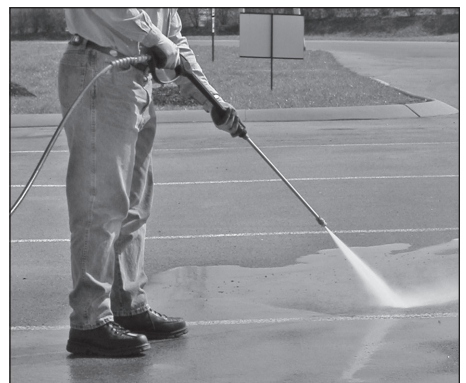
Figure 22 - Angle optimum par rapport à la surface à nettoyer
