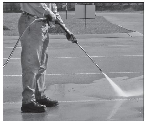
Figura 22 - Ángulo mejor para limpiar una superficie
