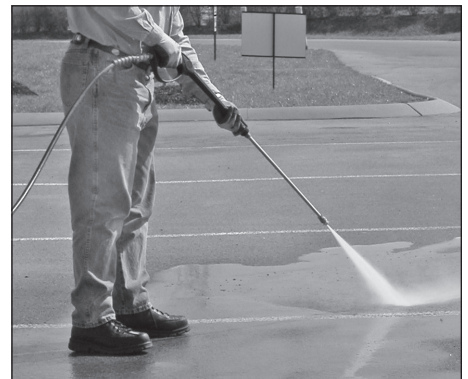
Figure 18 - Angle optimum par rapport à la surface à nettoyer
