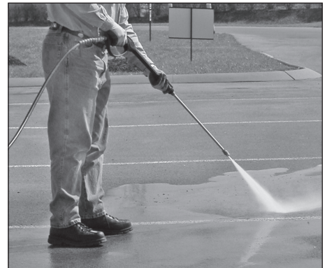
Figura 18 - Ángulo mejor para limpiar una superficie
